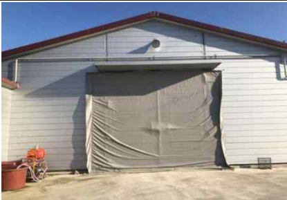
계사 틈새바람 방지 시공
