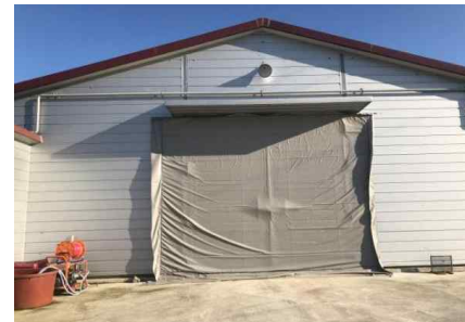
틈새바람 방지를 위한 계사 출입구 기밀성 시공
