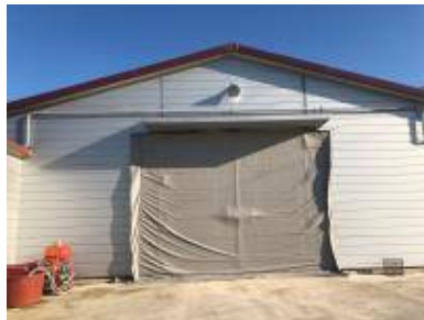
<틈새바람 방지를 위한 계사 출입구 기밀성 시공사례>
